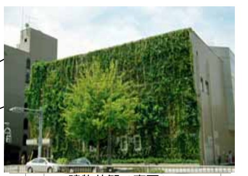
建物外観 (東面)
