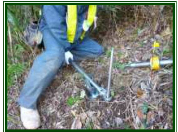
引抜き作業状況
