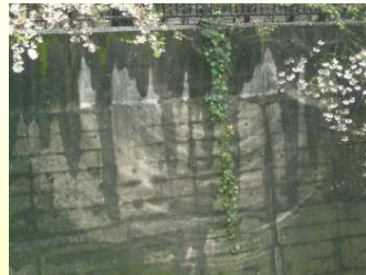
風で左右に揺らされているつる植物 動揺が続くと天端角部で切れてしまう
