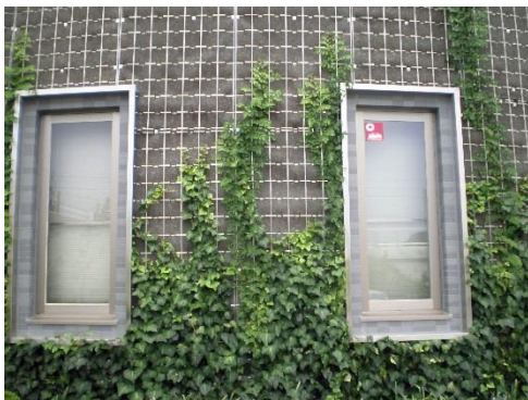
窓まわりに設置 施工後6ヶ月
