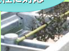
樹脂被覆鋼管支柱
