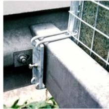
← 中央分離帯中間隔材へ取り付ける専用金具
