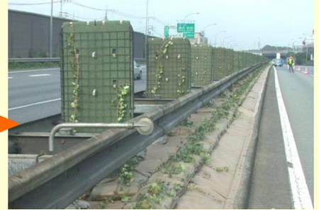
登ハンシートを本体に差し込み、専用の固定部材で簡単に取付けできます。
