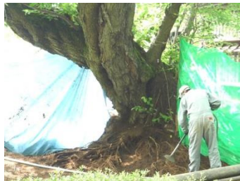
エアスコップを用いて掘削
