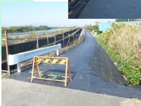
愛知県弥富 市2011年10月施工 黒色を表側にして敷設
