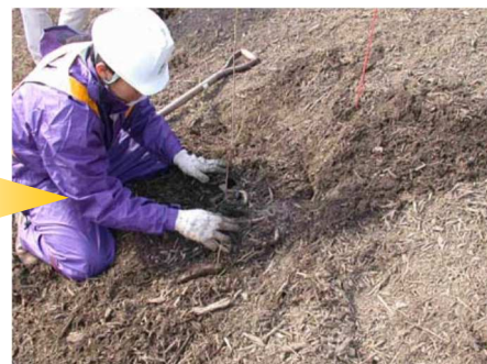
周囲のチップを均し設置完了
