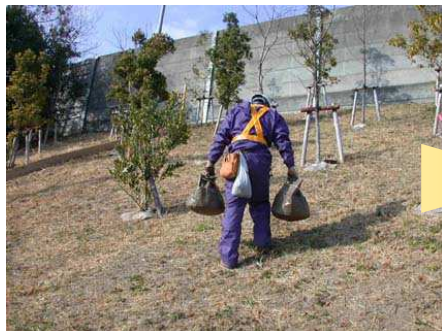
土壌15リットル充填、設置場所に運搬
