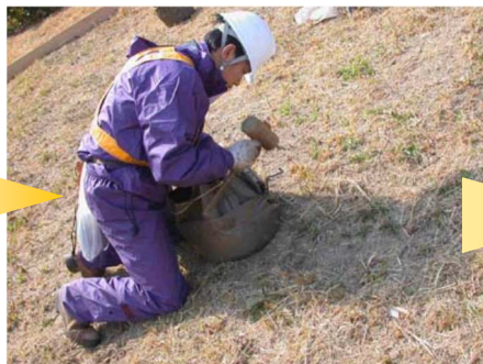
のり面に設置し、アンカーで固定
