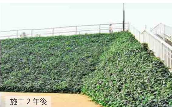
ヘデラ類を植栽し、PSマルチを敷設(静岡県)
