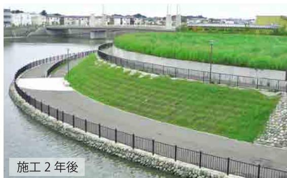
イワダレソウを植栽し、PSマルチを敷設(埼玉県)
