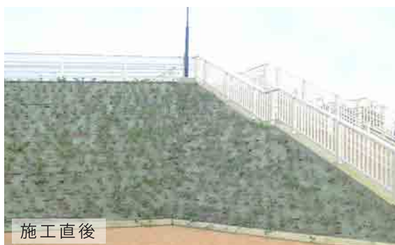
ヘデラ類を植栽し、PSマルチを敷設(静岡県)
