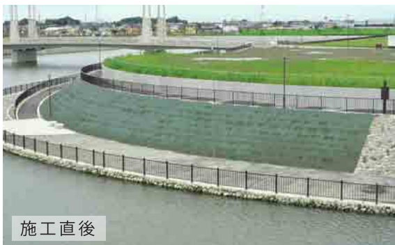
イワダレソウを植栽し、PSマルチを敷設(埼玉県)
