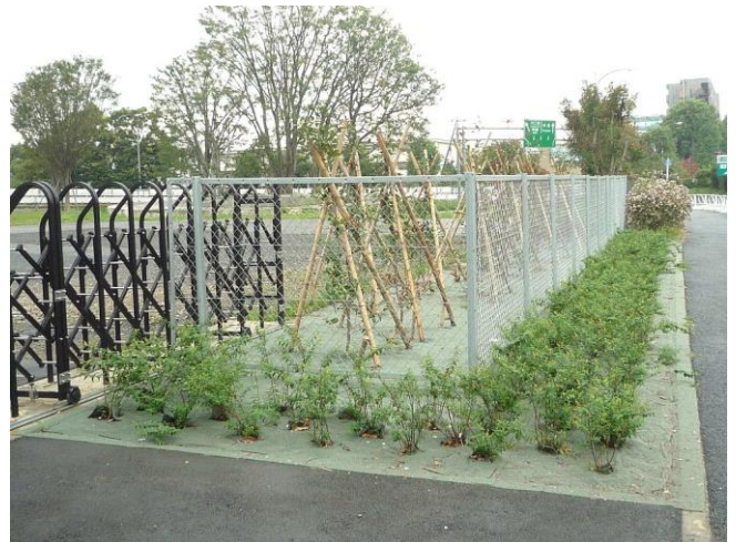
施工直後（東京都）
