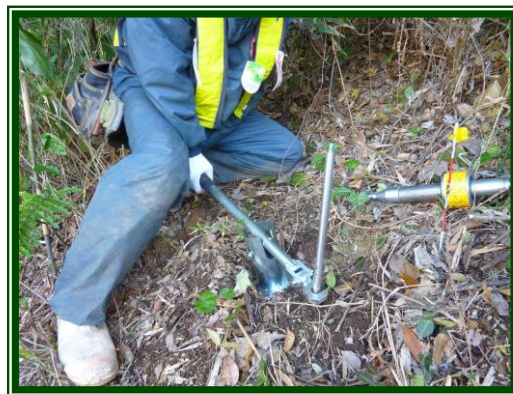
引抜き作業状況
