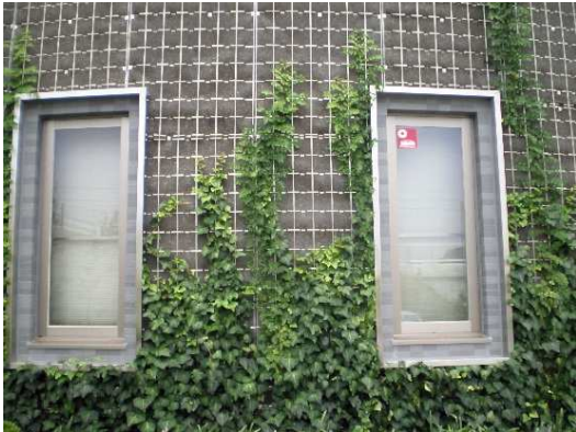
窓まわりに設置 施工後6ヶ月
