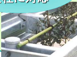
樹脂被覆鋼管支柱
