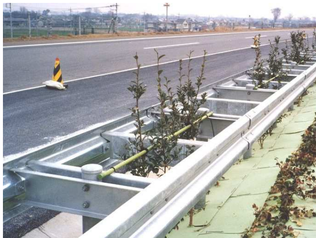
樹脂被覆鋼管支柱タイプ (関越自動車道 藤岡JCT付近)
