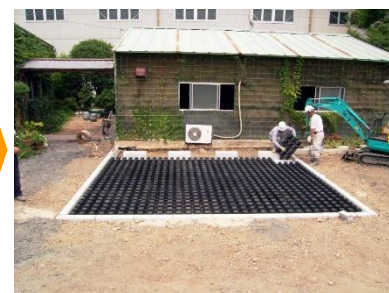
④GTPパネル設置
