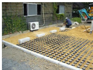
⑤客土敷均し
