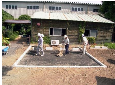
①路盤整正転圧
