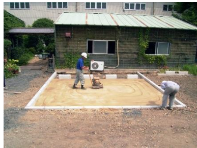
②クッション砂敷均し
