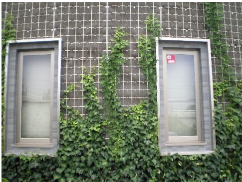
窓まわりに設置 施工後6ヶ月
